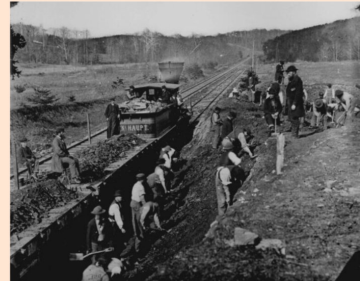
La construction du chemin de fer
